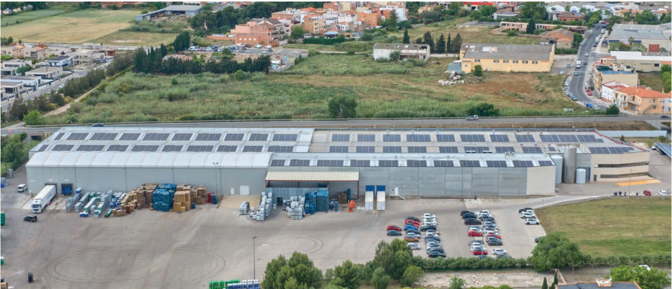
Vista aérea de la planta de producción Fruselva Spain en Riudoms. / Aerial view of the Fruselva production plant in Riudoms, Spain.
